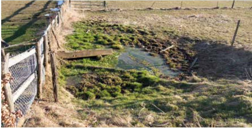
Avant la revitalisation de la source, la zone du captage ressemblait à un borbier (photo Parc Chasseral).
